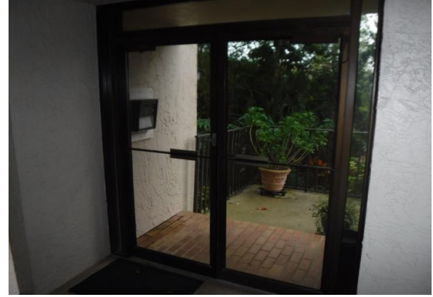
44 Bldg. #502 Glass Double Door Overview
